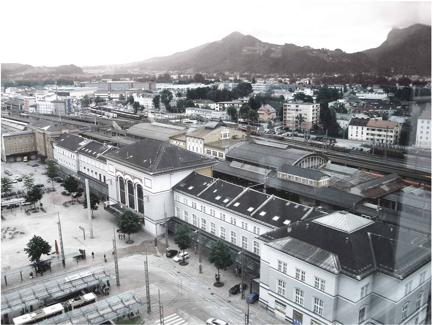
Bestandssituation vor dem Umbau
